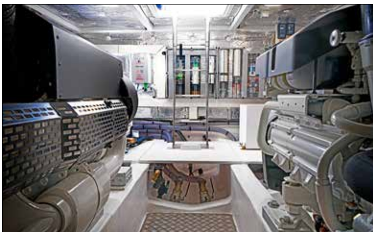
La salle des machines présente des dimensions impressionnantes et permet d'accéder facilement à toutes les parties techniques.
